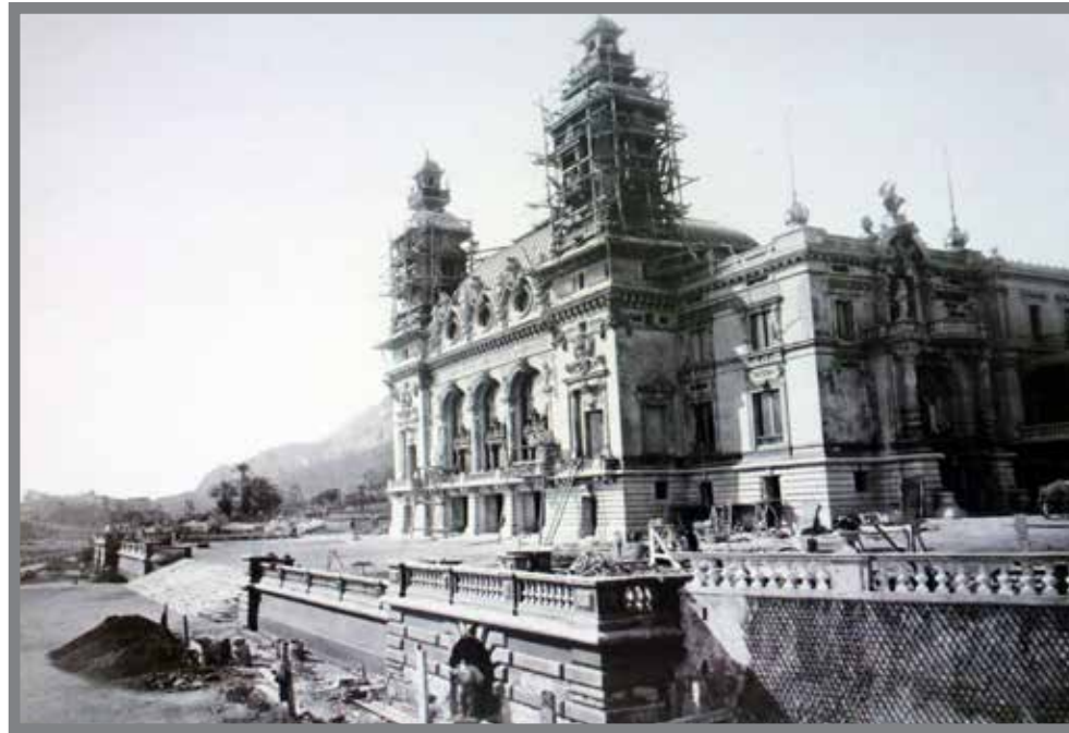
■ Fin des travaux de la façade sud de l'Opéra de Charles Garnier
